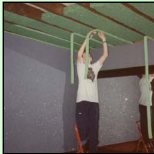
Plafondisolatie, tussen kepers
