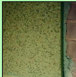
Accorub® gelijmd tegen muren
