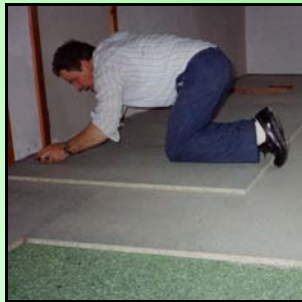
Accorub® toepassing voor vloeren bij renovatie
